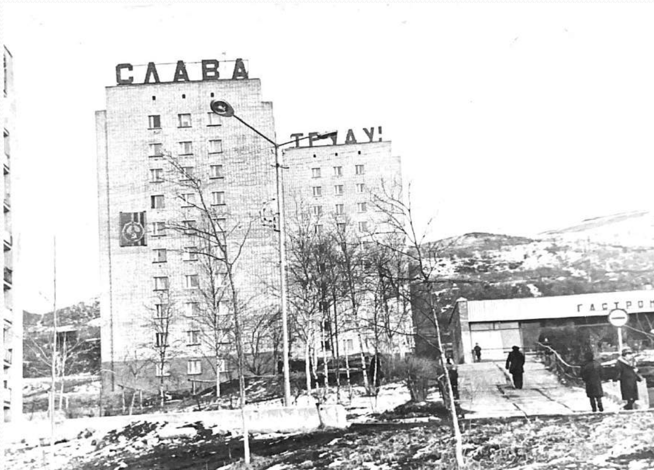
Первый гастроном построенный в 1 микрорайоне. Первые 9-ти этажные жилые дома в Славянке ул.50 лет Октября д. 11,13,15. 1988 год.
